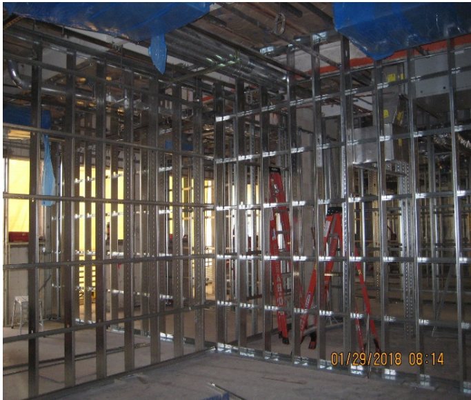
Steel stud wall framing
