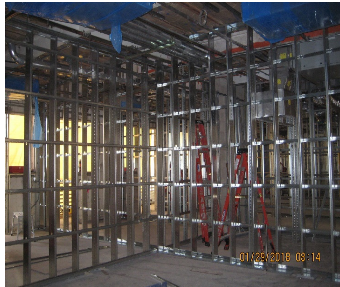
Steel stud wall framing
